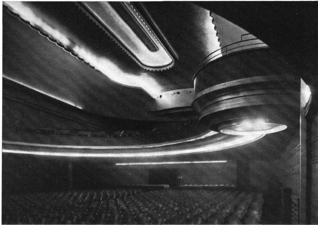
Abb. 40 / Union-Theater in München-Gladbach / Architekt: Ludwig Becker, Essen / Zuschauerraum
