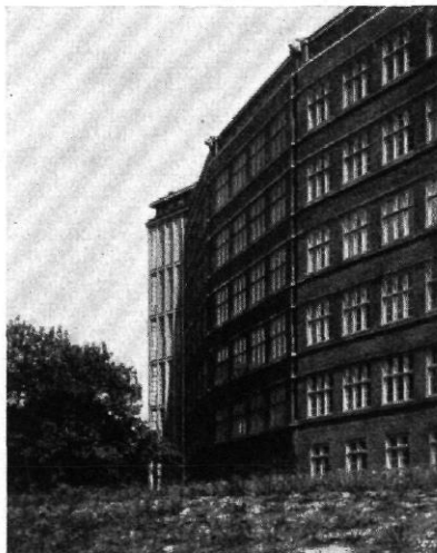
Abb. 4 / Erweiterungsbau des Ziviljustizgebäudes in Hamburg / Architekt: Fritz Schumacher,
