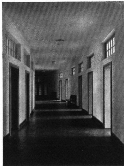
Abb. 10 / Erweiterungsbau des Ziviljustizgebäudes in Hamburg / Architekt: Fritz Schumacher,
