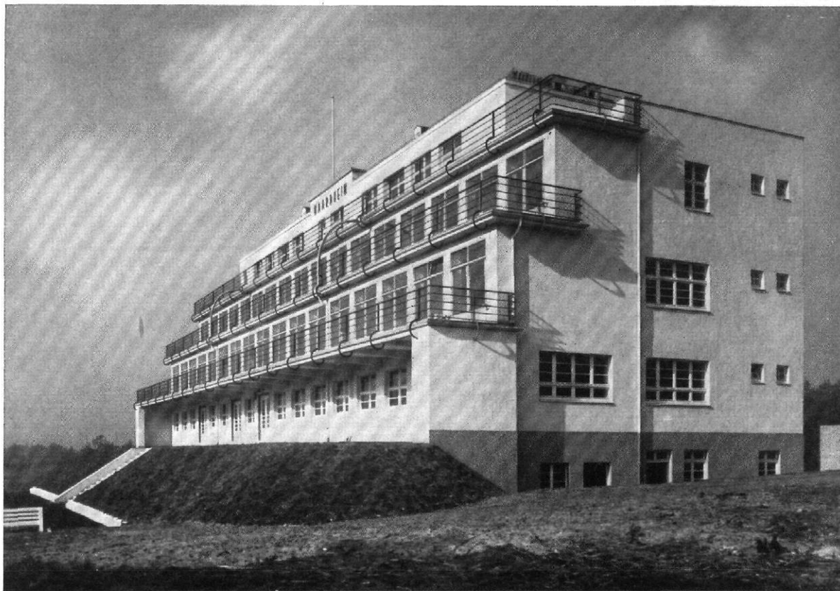
Abb. 31 / Heilstätte „Haardheim“ des Landkreises Recklinghausen / Architekten: G. Metzendorf und J. Schneider, Essen / Ansicht des Hauptflügels von Südosten
