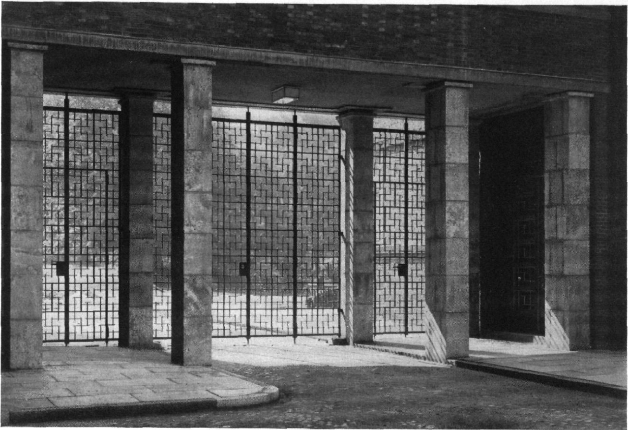
Abb. 7 / Erweiterungsbau des Ziviljustizgebäudes in Hamburg / Architekt: Fritz Schumacher, Hamburg / Durchfahrt zum Binnenhof
