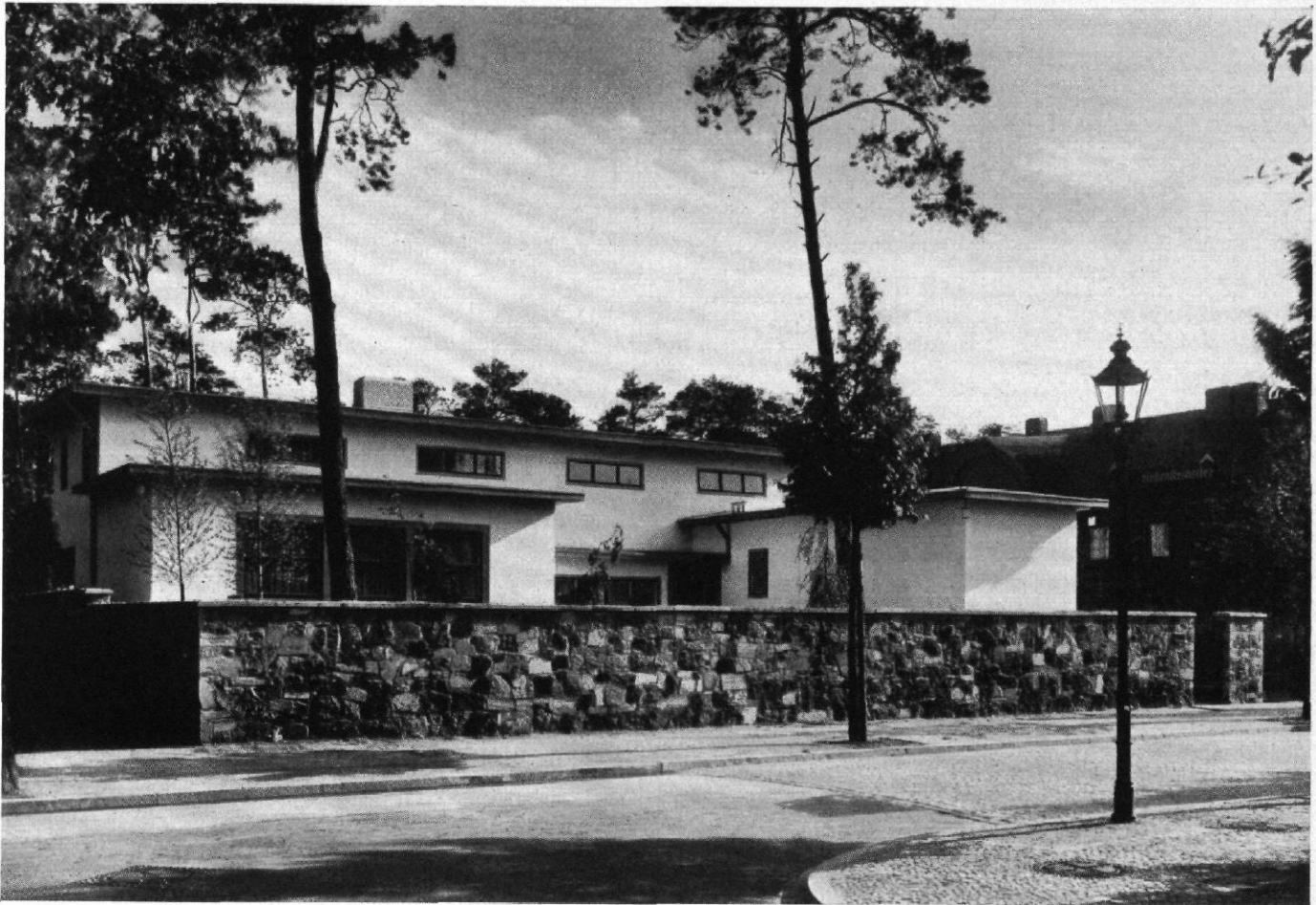
Abb. 1 / Haus Poelzig in Berlin-Westend / Architekt: Marlene Poelzig / Straßenseite
