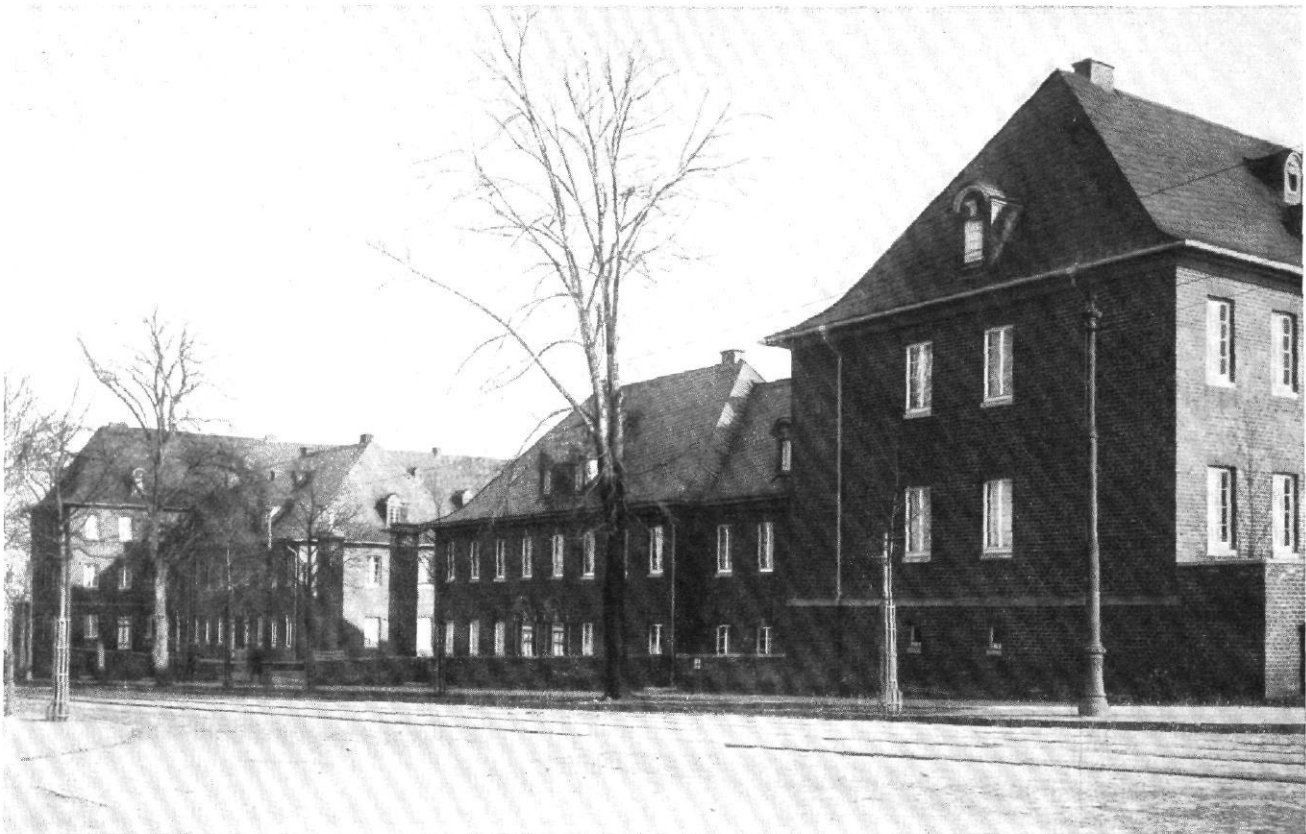
Abb. 5 / Umbauung des Sophie-Henschel-Platzes in Kassel / Architekt: Max Hummel / Ansicht von der Wilhelmsböber Allee
