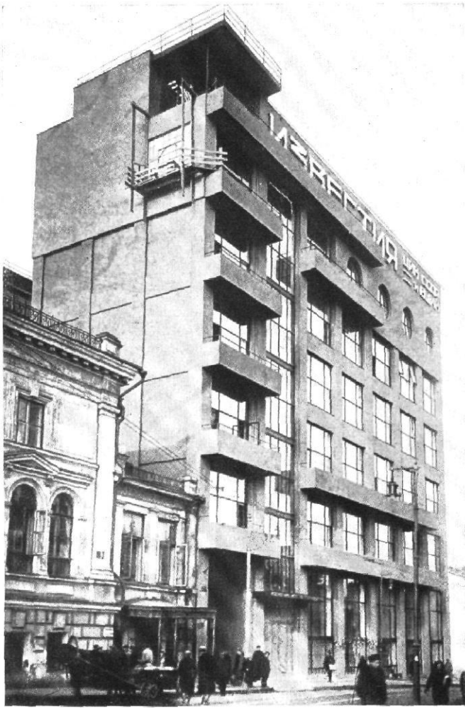
Abb. 15 / Zeitungsgebäude der „Izwestija“ / Moskau / 1927 / Architekt: G. B. Barchin / Straßenfront
