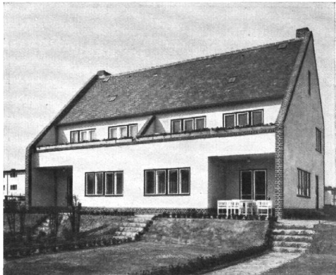
Abb. 10 / Berlin / Gagfah-Siedlung im Fischtalgrund / Doppelhaus / Architekt: Hans Poelzig, Berlin / Der an sich gute Baukörper wird karriert durch die heruntergezogenen und mit Rollschichtborte eingefaßten Giebel / Vgl. unten Abb. 11
