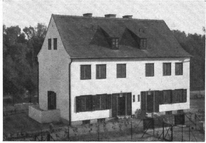
Abb. 16 / Berlin / Gagjah-Siedlung im Fischtalgrund / Doppelhaus / Architekt: Georg Steinmetz, Berlin / Eingangsseite
