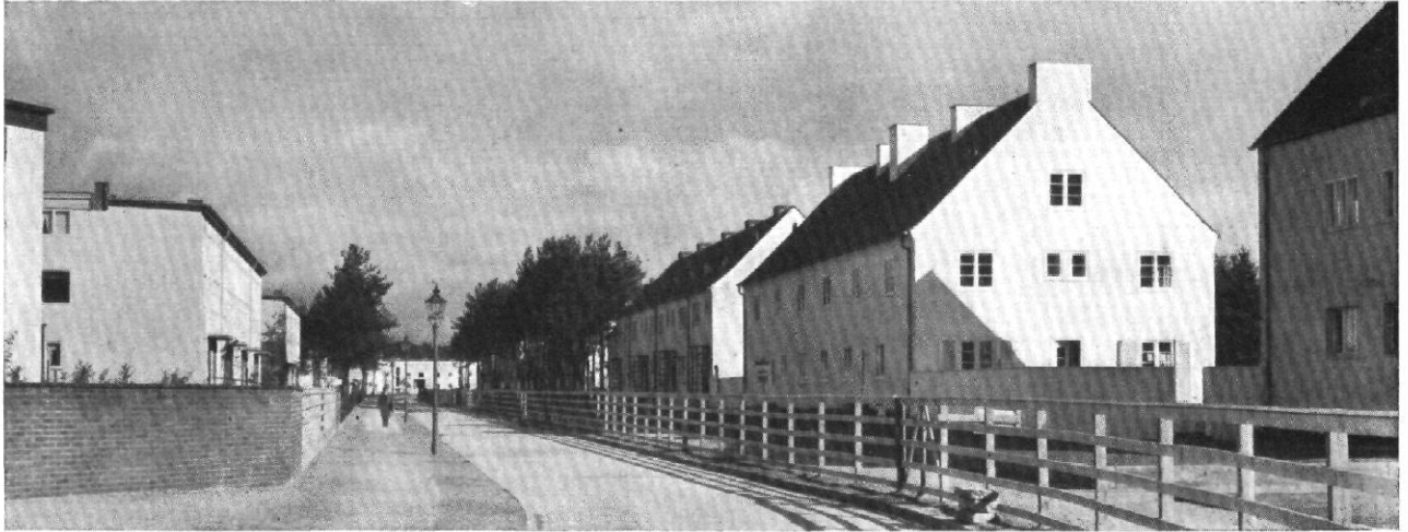
Abb. 2 | Berlin / Gagfah-Siedlung im Fischtalgrund / Blick von der Riemeisterstraße nach Norden. Links die flachgedeckten Häuser der Gehag% bei denen man durch spielerische^ teils schräge, teils wagerechte Bretterverkleidungen die Schwierigkeiten der Giebellösung zu bewältigen versucht hat.
