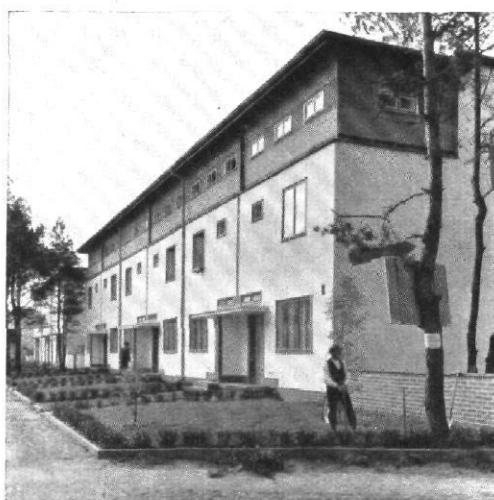
Abb. 8 I Reihenhäuser der „Gehag“, gegenüber der „ftagfah“-Siedlung am Fischlaigrund / Der von den unbedingten Anhängern des flachen Daches für überflüssigerklärte Bodenraum erscheint hier als volles Stockwerk und wird durch besondere farbige und plastische Ausbildung zum architektonischen Hauptstück
