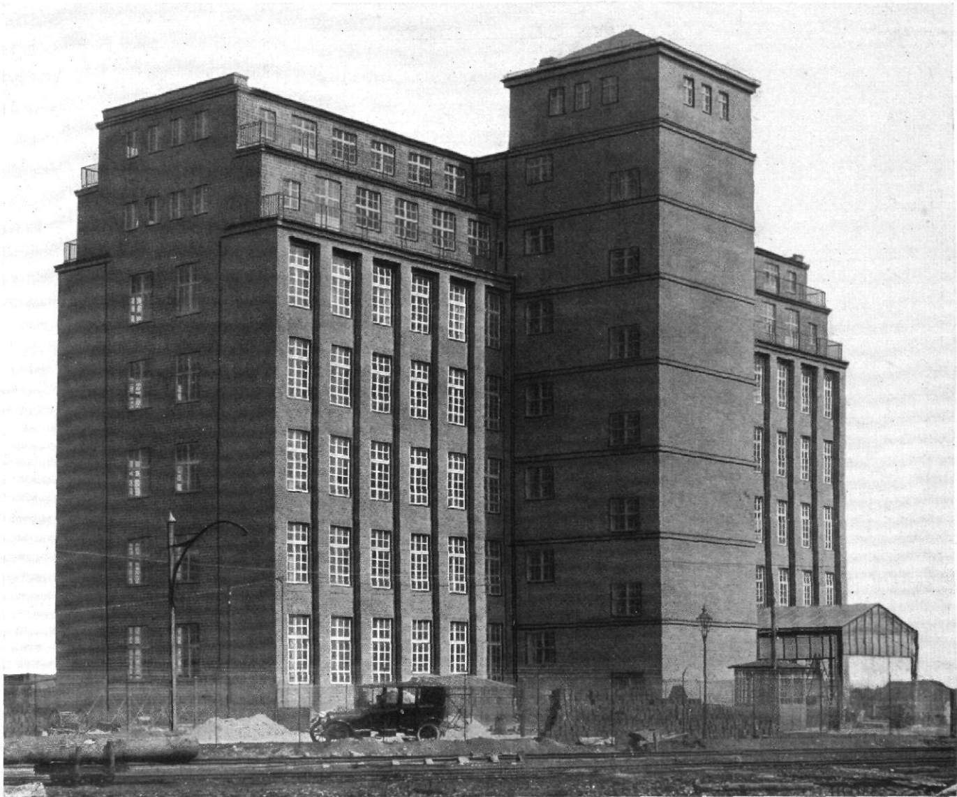
Abb. 1 / Siemenswerke, Blockwerk II von Südwesten / Architekt: Hans Hertlein, Berlin
