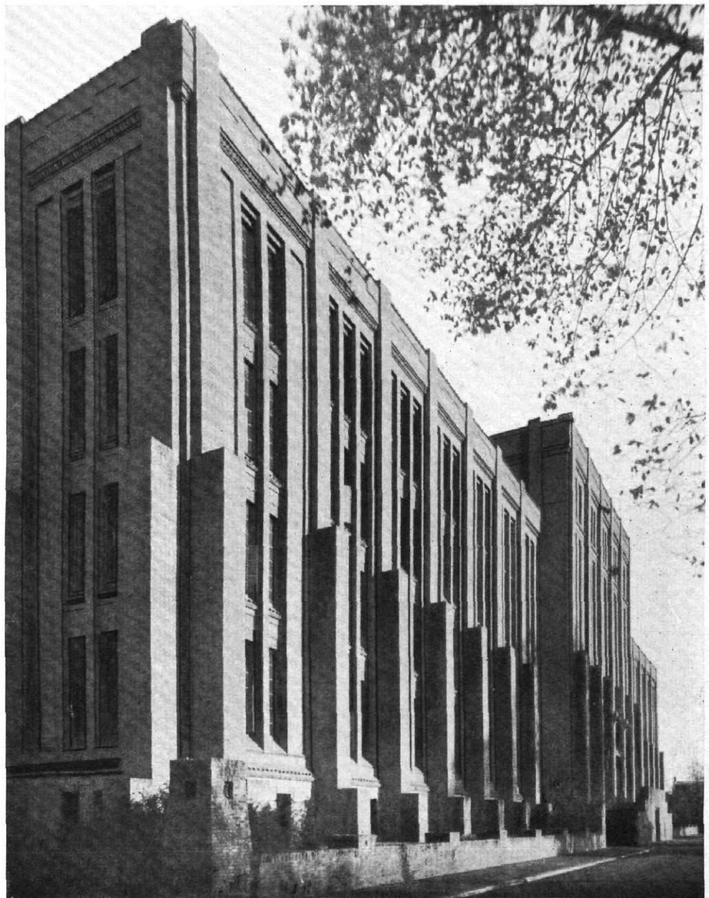
Abb 3-5 / Verwaltungsgebäude der Niederländischen Eisenbahnen in Utrecht Architekt: G. W. van Heukelom
