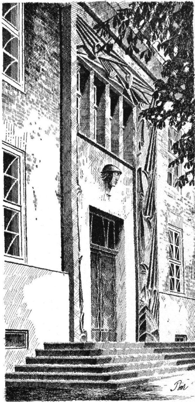
Abb. 1 / Bürohaus „Glückauf“ in Essen. Eingang Bismarckstraße Architekt: Ernst Bode, Essen
