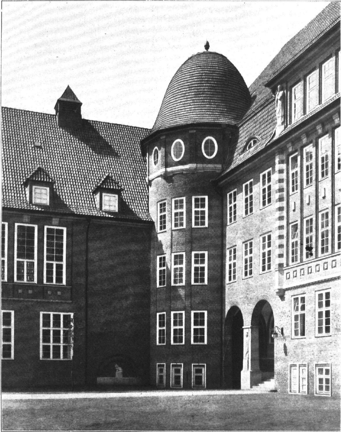
Fritz Schumacher, Architekt, Hamburg: Eingang der Hansenschule in Bergedorf
