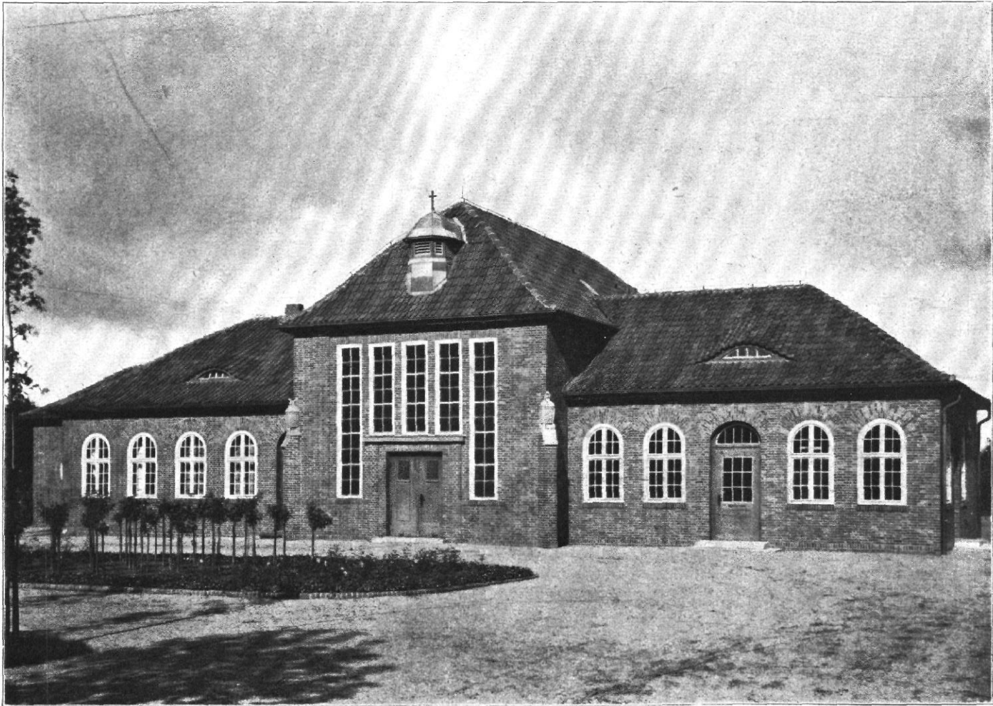
Fritz Schumacher, Architekt, H m ω # : Leichenhalle
