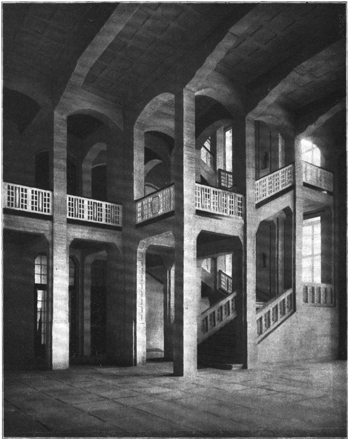
Fritz Schumacher, Architekt, Hamburg; Treppenhaus der Kunstgewerbeschule
