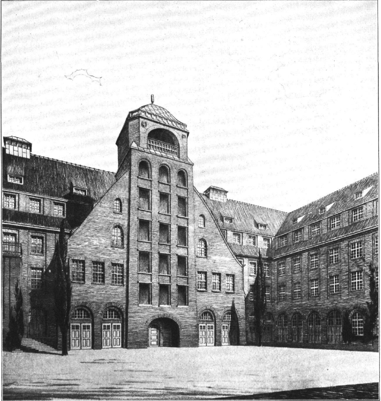
Fritz Schumacher, Architekt, Hamburg; Übungsturm der Hauptfeuerwache
