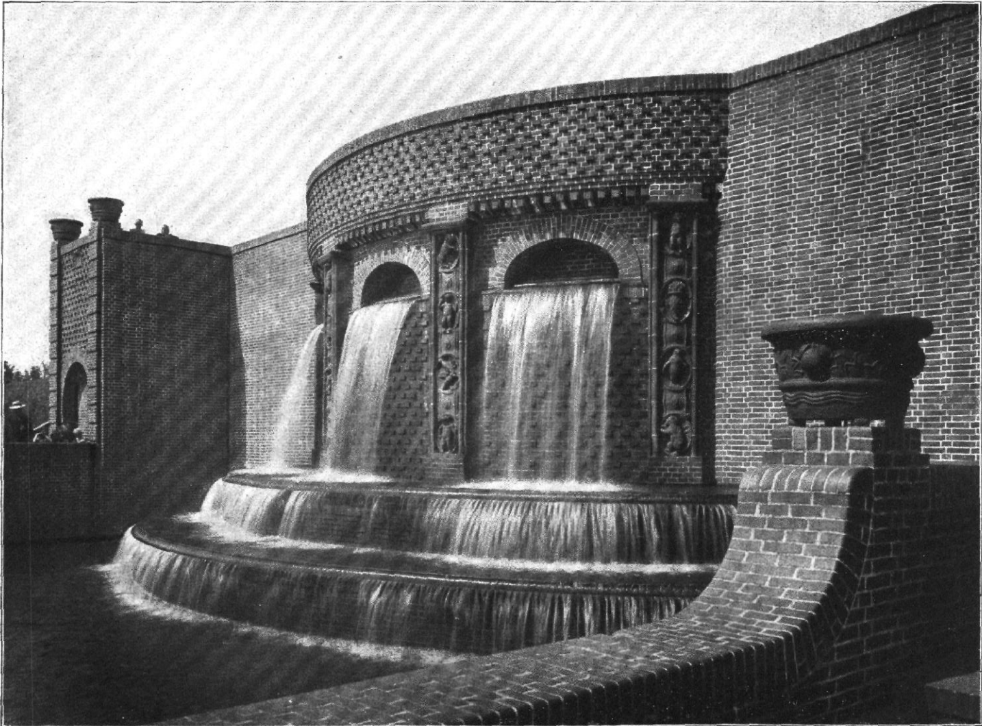
Fritz Schumacher, Architekt, Hamburg: Kaskade im Stadtpark
